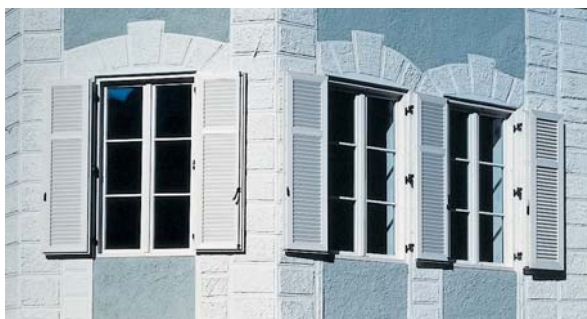
Klappladenbefestigung direkt am Mauerwerk mittels Mauerkegel
